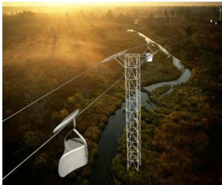
Рис. 2. Грузопассажирская трасса моноСТЮ (высота опор 20—30 м, длина пролетов 200—400 м)
